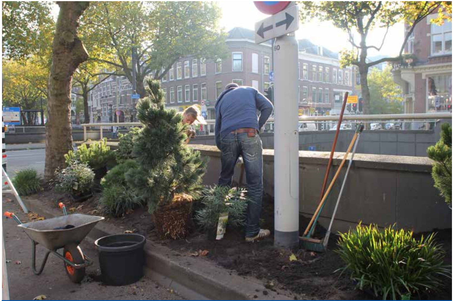
De aanleg van de proefstrook met planten die fijnstof opvangen bij de kruising 's Gravendijkwal-Nieuwe Binnenweg door Stadslab Luchtkwaliteit. Foto: Léon Richard
